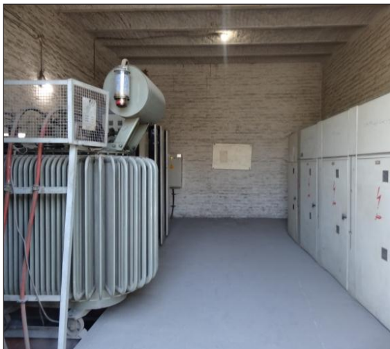
شکل ۲- ترانسفورماتور زمینی
